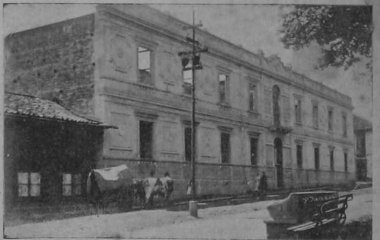
PALACIO MUNICIPAL DE ALAJUELA, EN CONSTRUCCION
